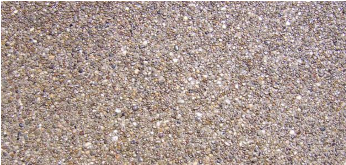
Figur 7-17: Eksempel på frilagt betonggulv
