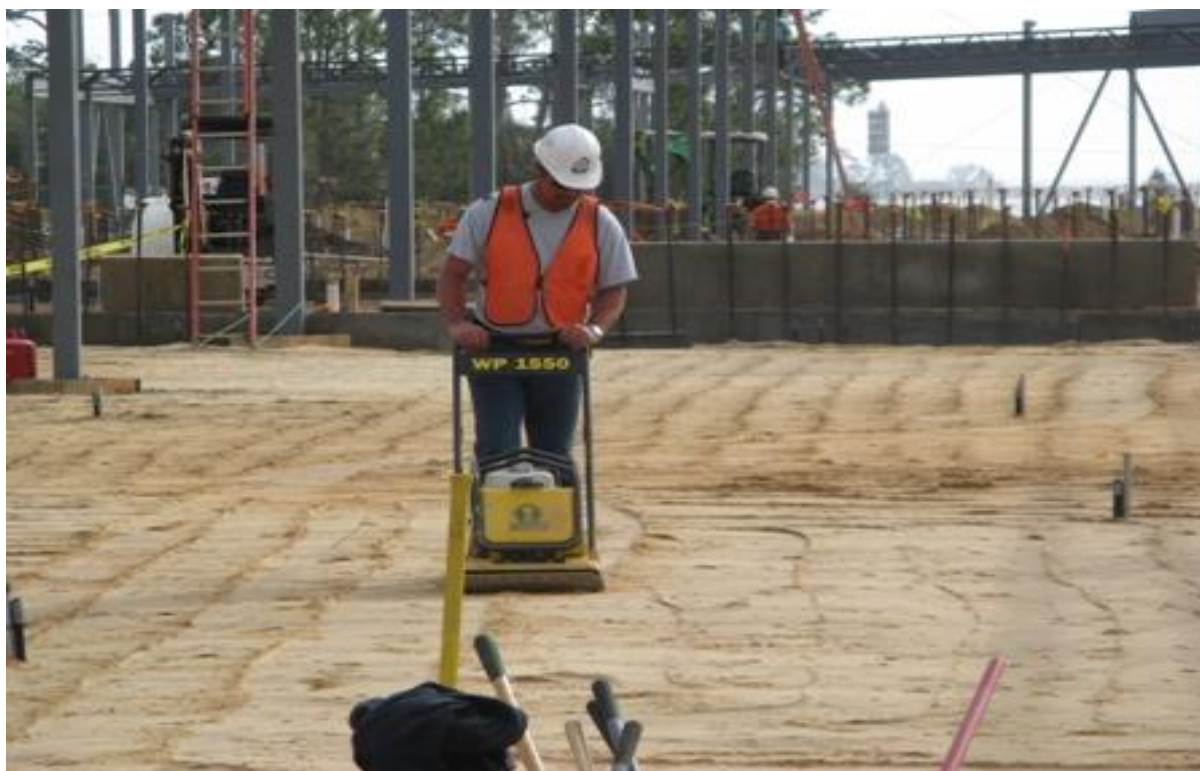
Figur 6-1: Komprimering og avretting av bærelag
