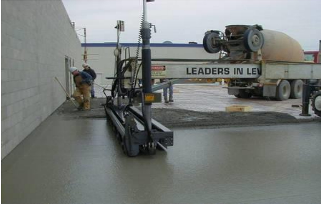
Figur 6-4: Avtrekking med laserstyrt maskin
