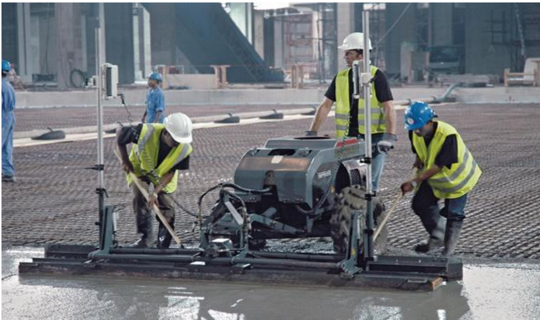
Figur 6-5: Avtrekking med balansert laserstyrt avtrekker på hjul
