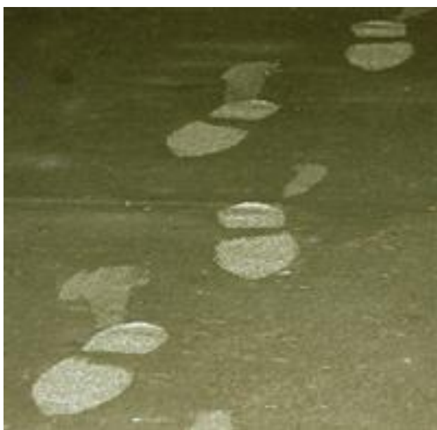
Figur 6-6: Fotavtrykk i betongen som indikerer at det er klart for skuring. I praksis bruker en erfaring og skjønn.
