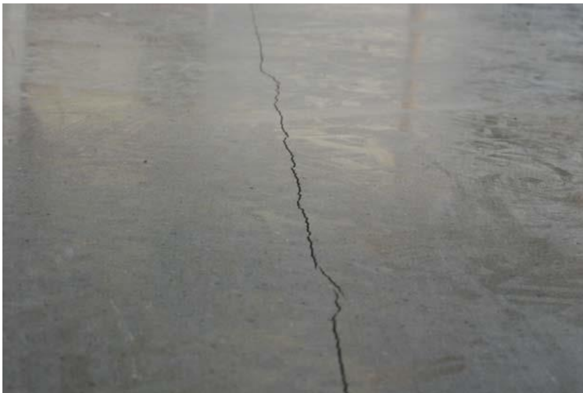
Figur 7-3: Eksempel på et grovt svinnriss
