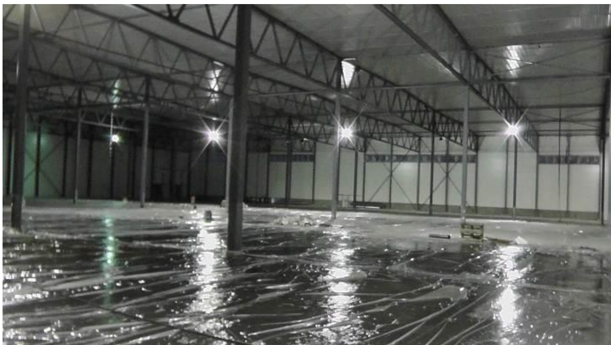
Figur 6-11: Tynn folie lagt over ferdig gulv umiddelbart etter glatting
