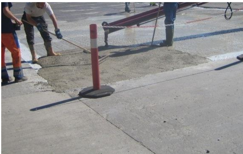
Figur 5-12: Liming av påstøp med epoxy i randsonen og sementbasert heftbro på de store arealene
