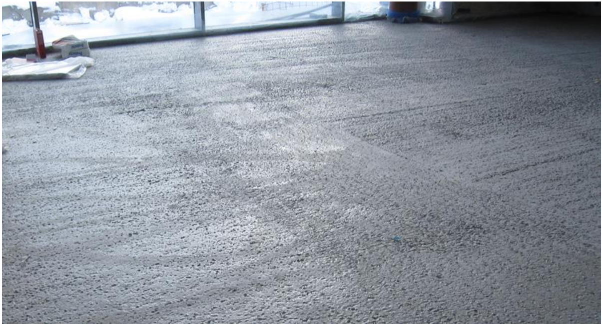
Figur 7-10: Avtrukket overflate
