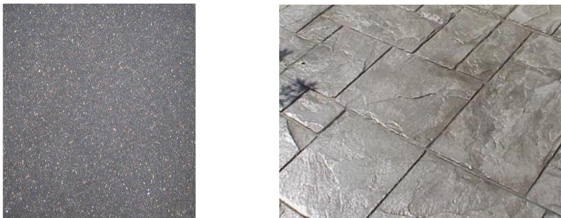
Figur 7-16: Eksempler på mønstret betonggulv
