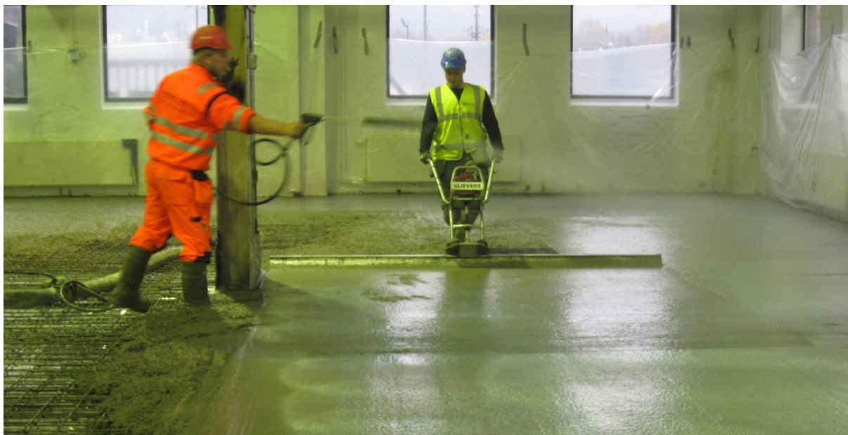
Figur 6-3: Bruk av motorisert avretter
