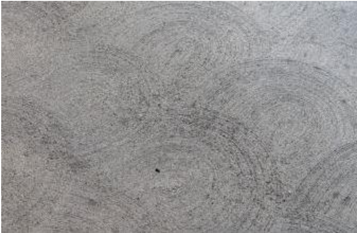
Figur 7-12: Eksempel på mønsterskurt betonggulv
