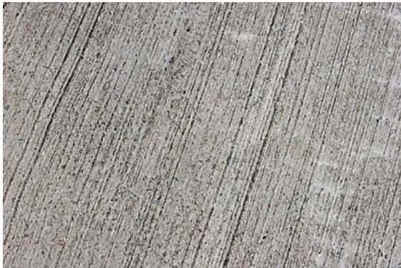
Figur 7-13: Eksempler på kostet overflate
