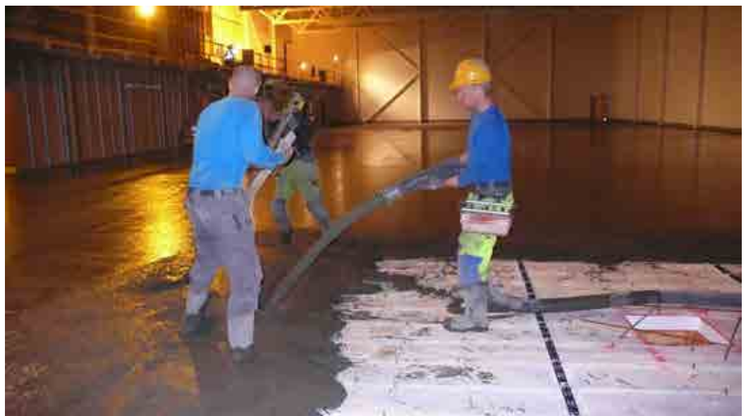
Bilde 1: Støping av «Mapecrete System» gulv på 1300 m 2 uten fuger.
